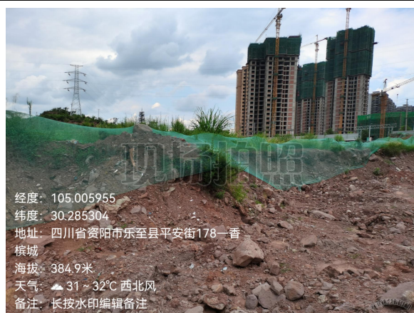
西侧挖方区（照片编号 4#，拍摄方向：西北）
