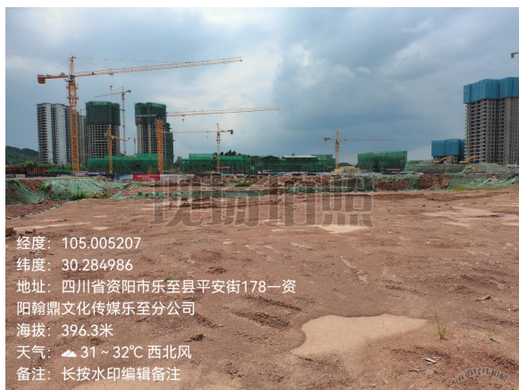
西侧挖方区（照片编号 1#，拍摄方向：西）
