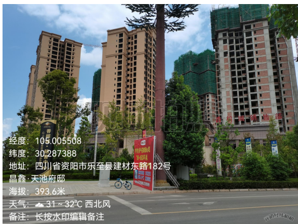
东北侧外环境（在建小区）
