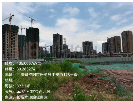
东南侧外环境（荒地）
