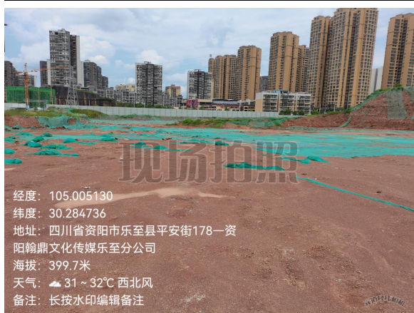
西侧挖方区（照片编号 3#，拍摄方向：东北）
