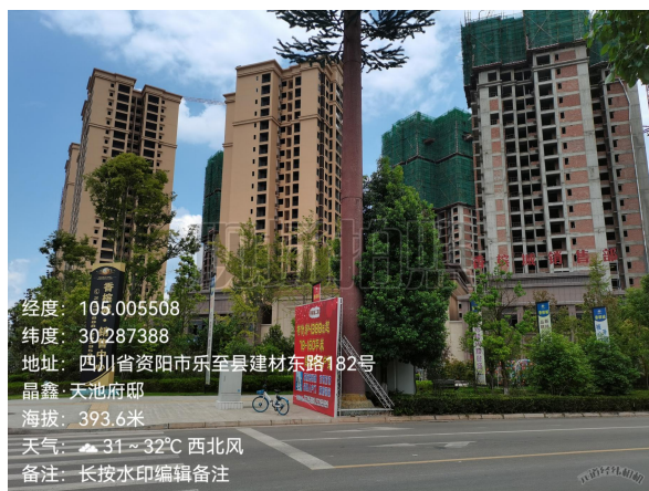
东北侧外环境（在建小区）
