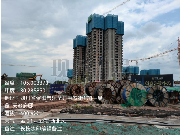
西侧外环境（在建小区）
