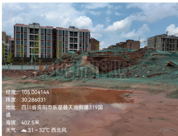
西侧挖方区（照片编号 3#, 拍摄方向：西北）
