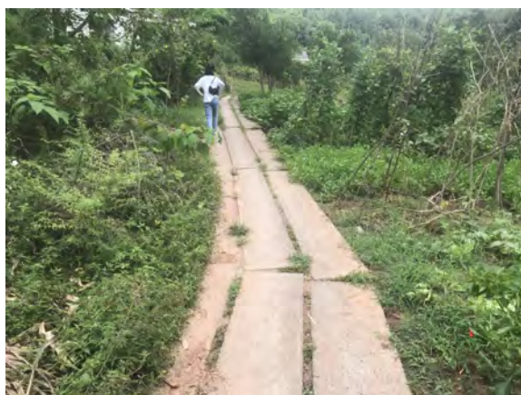
地块内东北侧（道路）
