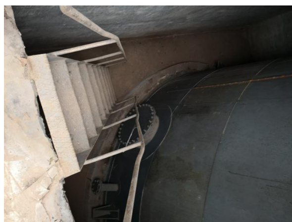
二分厂及配件厂大件区油库
