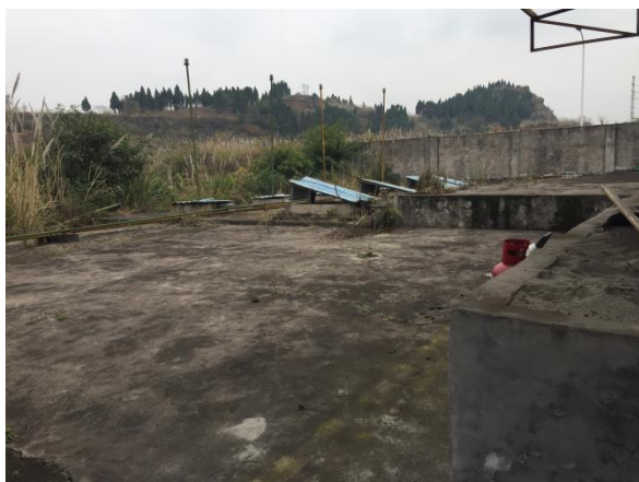
总部机关及一分厂油库
