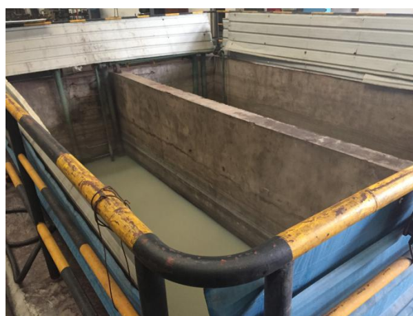
配件厂机体加工区循环水池
