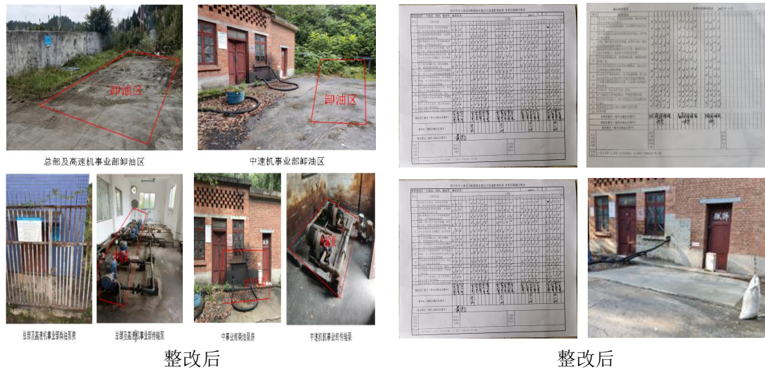
整改后 整改后 图 2 油泵房记录及部分跑冒滴漏问题整改情况
