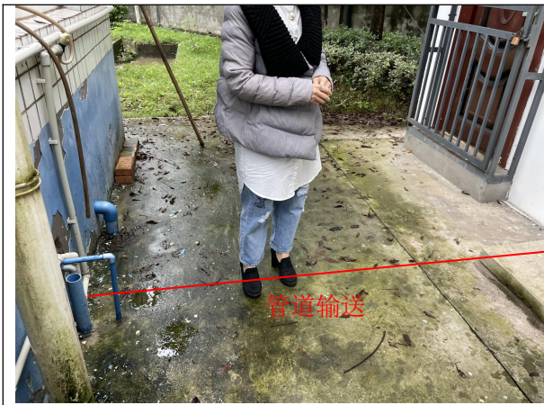
盐酸管道输送（地下管道）
