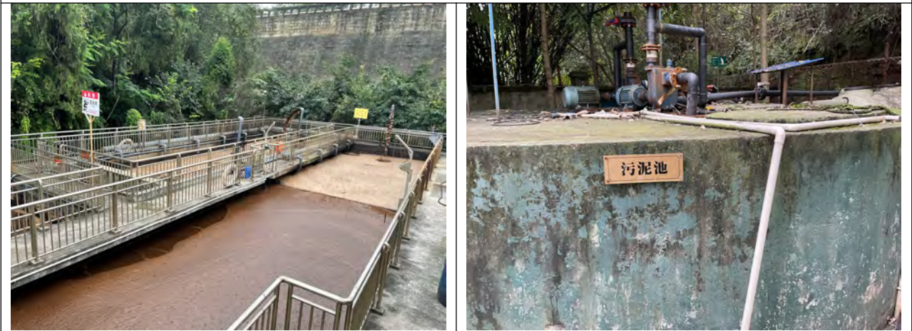
渗滤液处理系统各个池体
