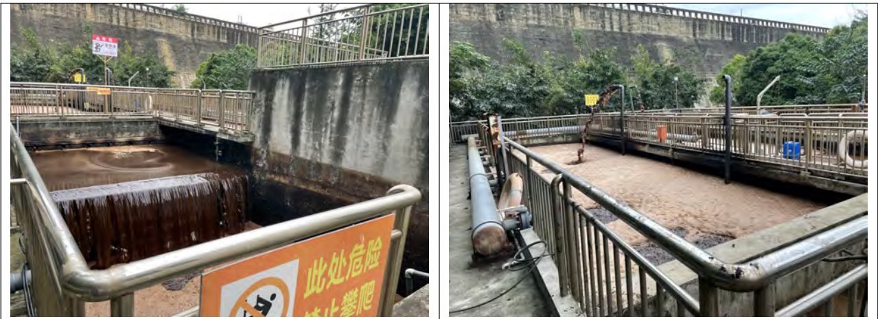
渗滤液处理系统各个池体
