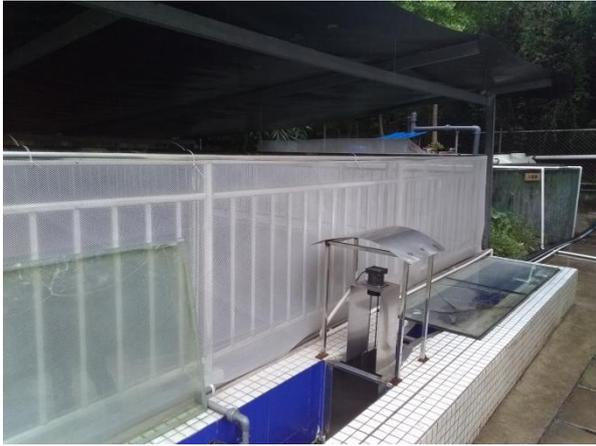
渗滤液处理车间排水口紫外线处理装置
