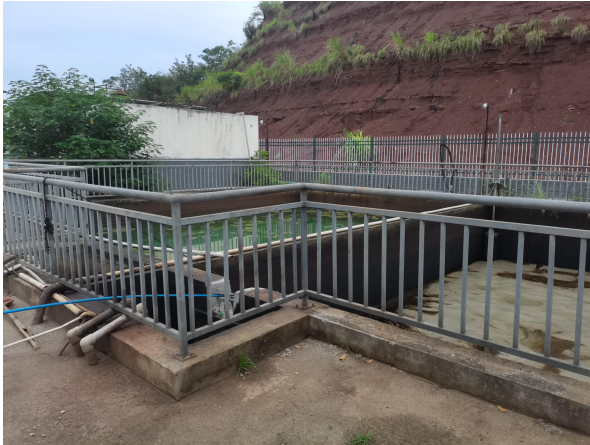
污水处理站池体
