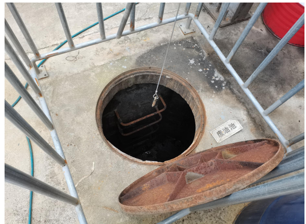
污水处理站内废油池
