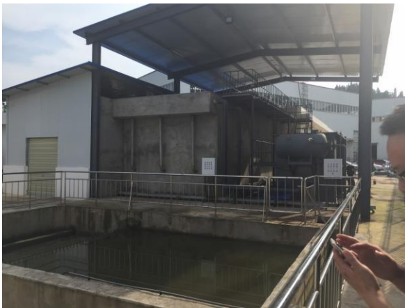
污水处理站池体
