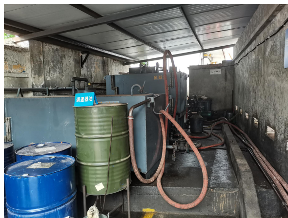
机车事业部柴油罐加油处
