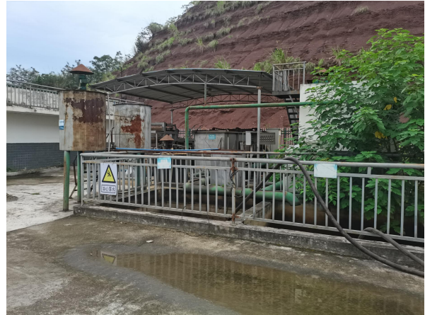
污水处理站池体
