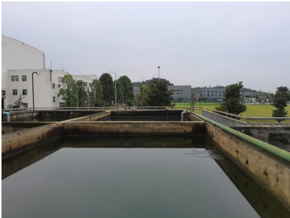
污水处理站池体
