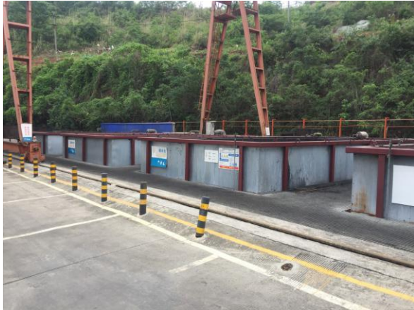
机车事业部机车修理区碱水池
