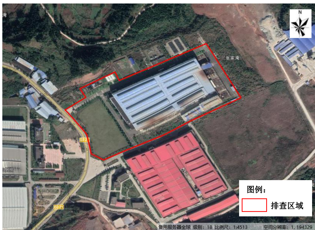
中车资阳机车有限公司资阳锻造分公司、曲轴分公司水压机工区
