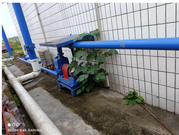
集团总部污水处理站废水输送管道
