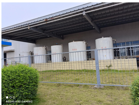
集团总部机油、齿轮油、防冻液、动力转向油储罐
