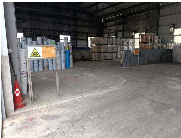
危废暂存间（液态物料区围堰）
