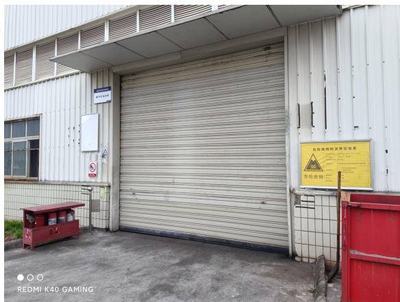
零部件产业园卸油区
