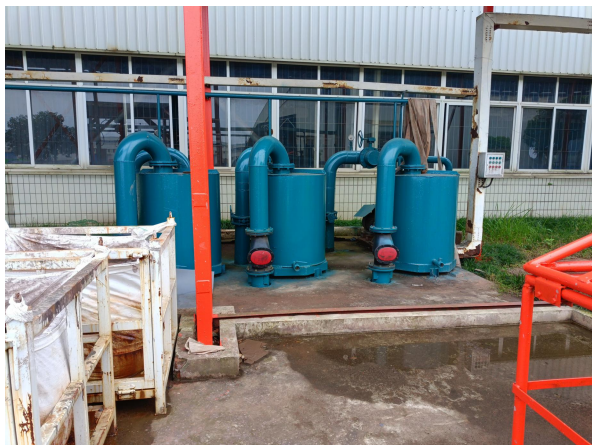
零部件产业园涂装废水暂存池（地下）
