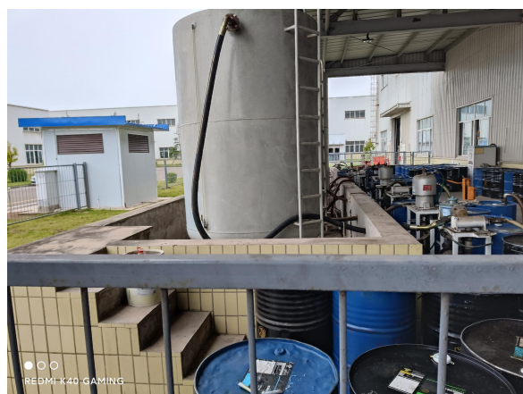
集团总部机油、齿轮油、防冻液、动力转向油储罐
