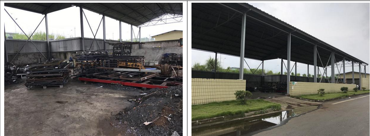
一般工业固废暂存点
