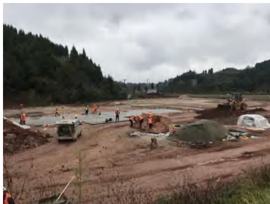
地块东侧外环境（在建项目部）
