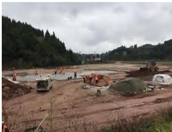
地块东侧外环境（在建项目部）
