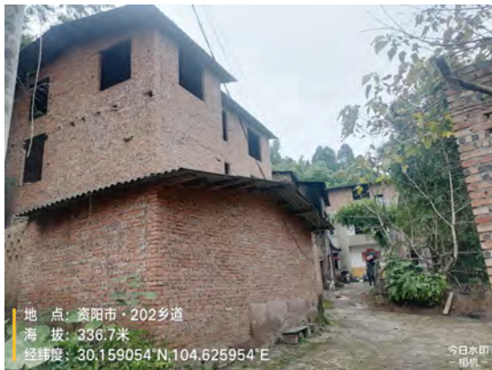
地块外南侧居民（已搬迁，房屋尚未拆除）
