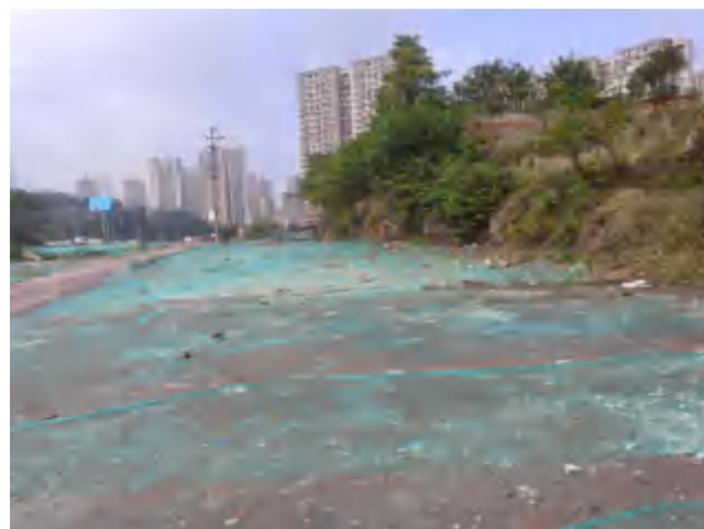
地块内南侧（原坤鹏机械租赁公司处）
