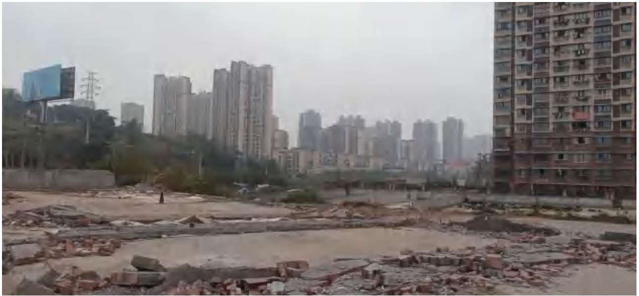
地块内西北侧（原食品中转仓库）
