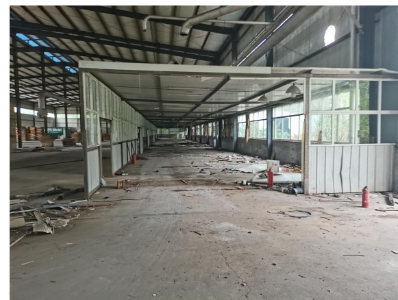
地板、指接板车间喷漆室
