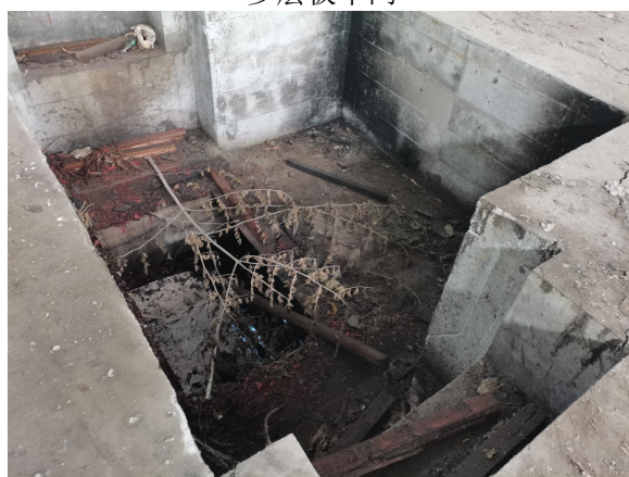
多层板车间热压区基坑
