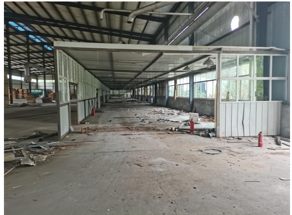
地板、指接板车间喷漆室
