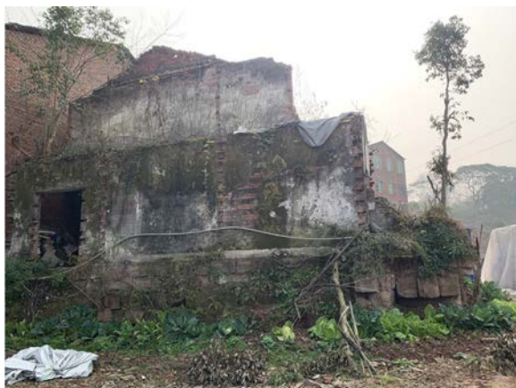
地块内现状（拆迁居民区，照片编号 7#，拍摄方向：南）
