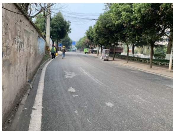
北侧外环境（海慧路，照片编号 S1，拍摄方向：西北）
