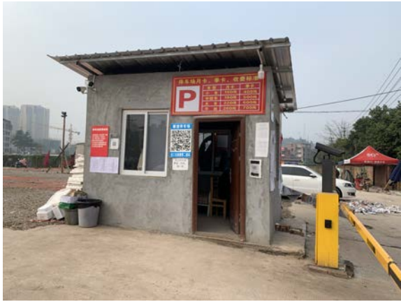
地块内现状（门卫室，照片编号 1#，拍摄方向：西）
