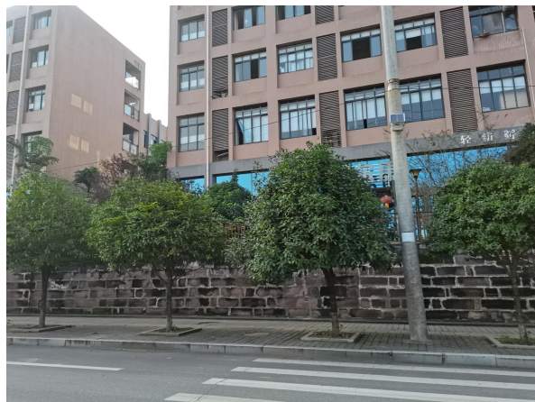
地块西侧（四川大和鞋材物流有限公司租用生产厂房）
