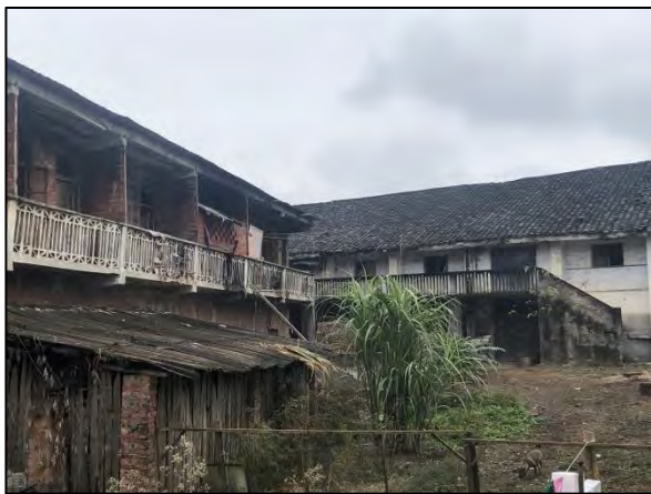
地块内北侧安岳县粮站 49 号仓库及粮站 职工用房
