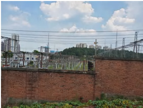
东北侧外环境（变电站，照片编号 S1，拍摄方向：北）
