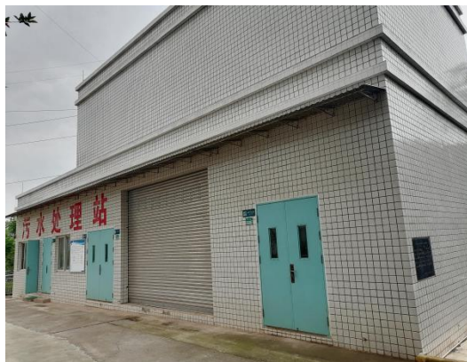
污水处理站设备间
