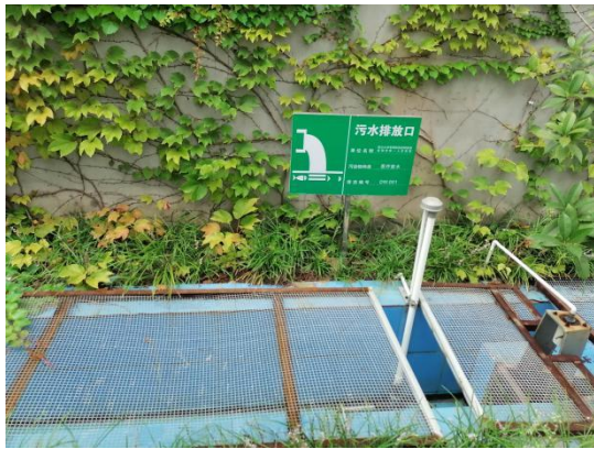
污水处理站排放口
