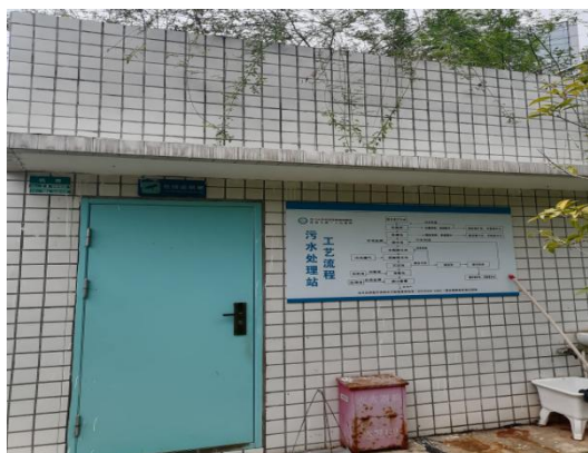
污水处理站在线监测室
