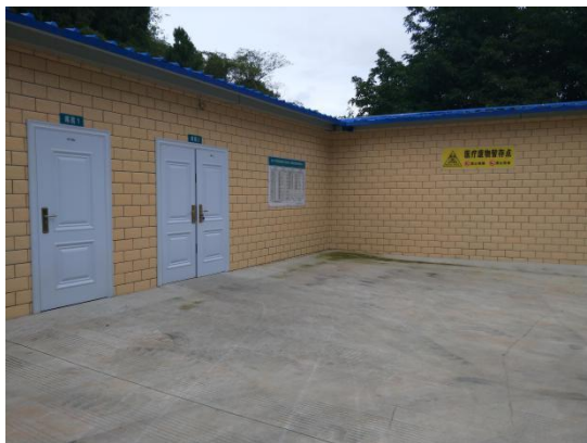
危险废物暂存间
