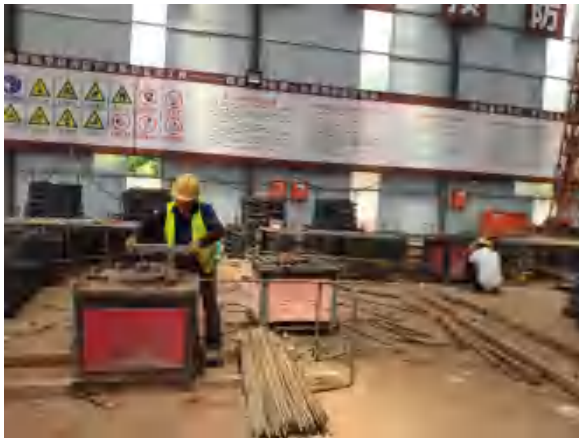
钢筋加工车间
