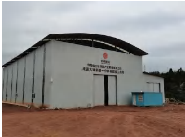
地块内钢筋加工车间
