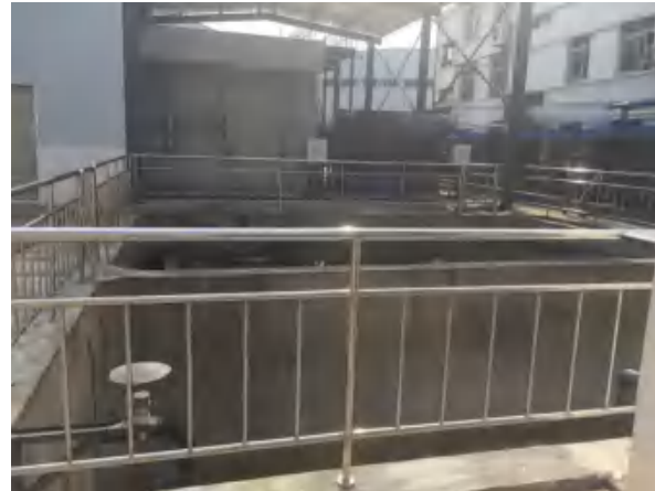
机车事业部污水处理站
