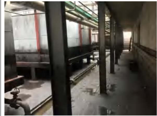
机车修理区碱水池
