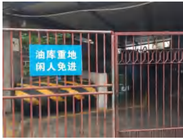
机车事业部油罐区
