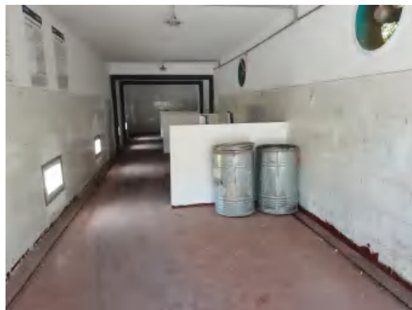
钢结构事业部危废暂存间（废油桶）
