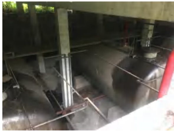
废弃油罐区机油罐
