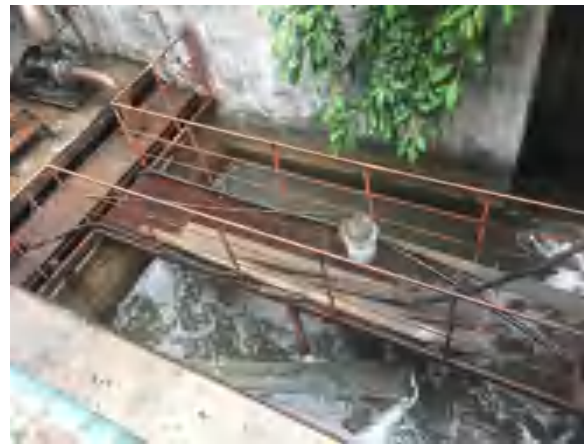
钢结构事业部面漆水旋池
