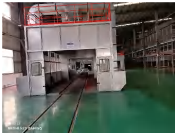
集团总部喷漆车间（有地下漆泥池）
