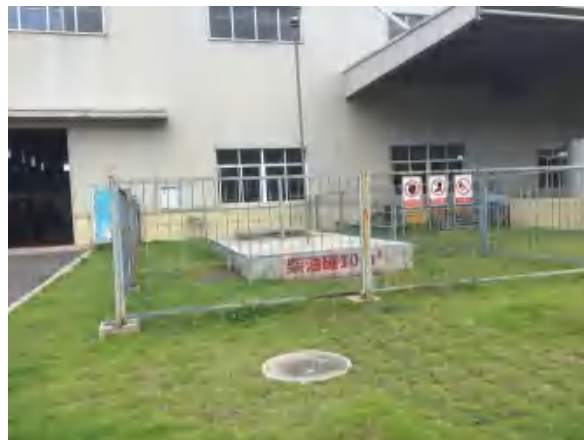
集团总部地下柴油储罐
