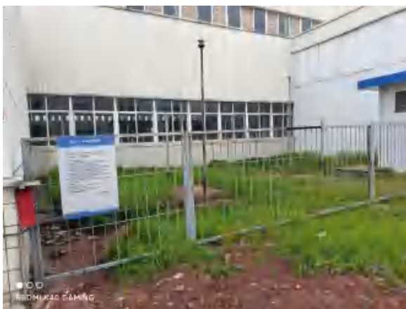
零部件产业园柴油地下储罐
