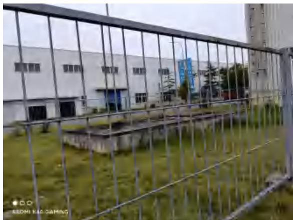
集团总部地下汽油储罐
