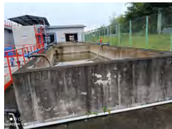
集团总部污水处理站
