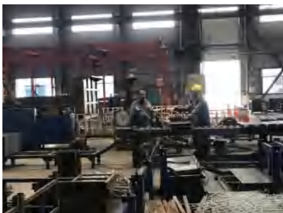
生产车间焊接
