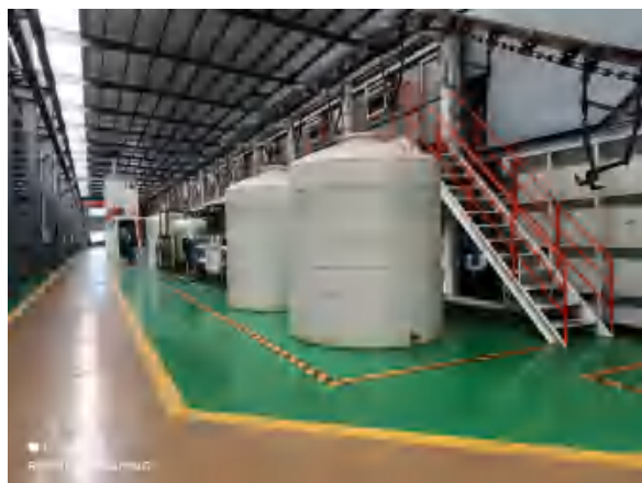
集团总部涂装车间（电泳线）
