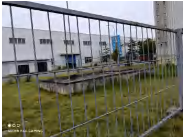
集团总部地下汽油储罐
