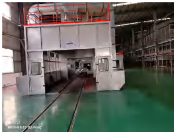
集团总部喷漆车间（有地下漆泥池）
