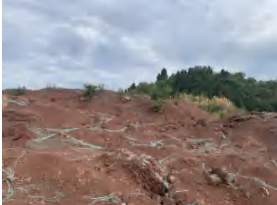
地块内现状（荒地，照片编号 9#，拍摄方向：东南）
