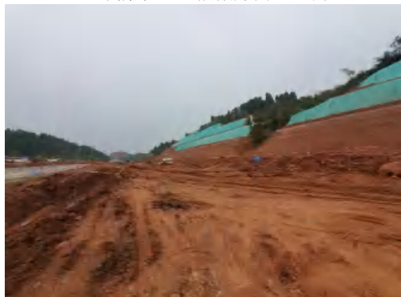
西北侧外环境 （照片编号 S6，拍摄方向：西北）
