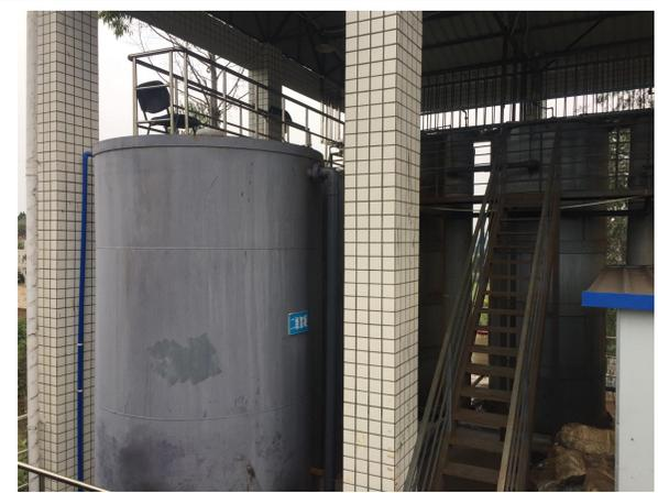
渗滤液处理站接地储罐（二级絮凝）
