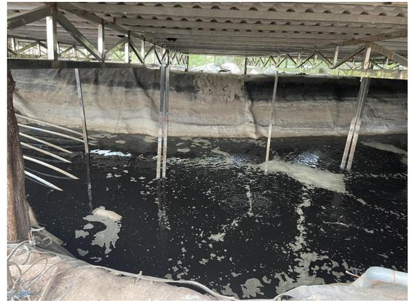
2#应急池和1#应急池内部情况（采用水泥硬化+土工布+土工膜+土工布防渗）
