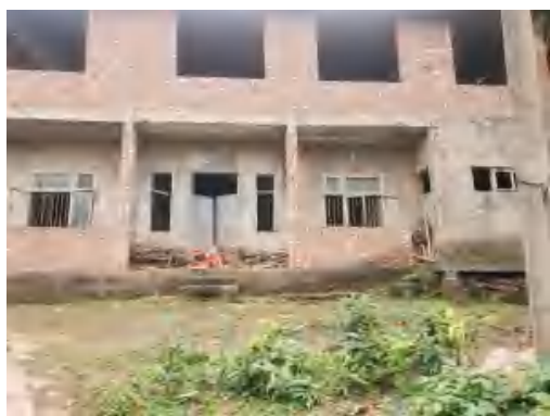
地块内东侧残留房屋
