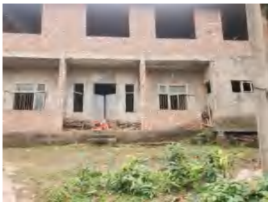
地块内东侧残留房屋
