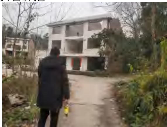
地块内东侧残留房屋
