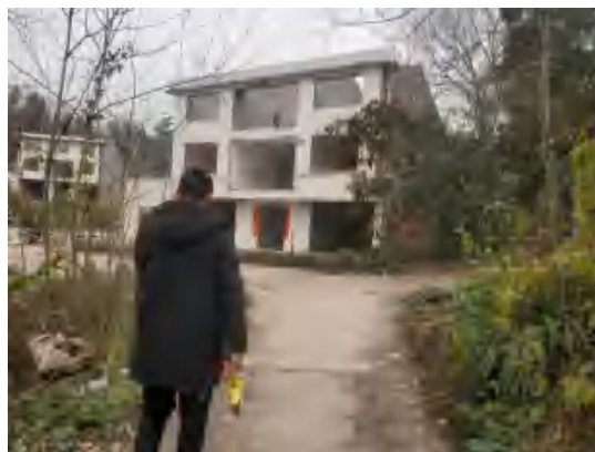
地块内东侧残留房屋
