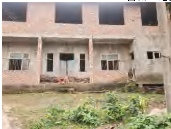
地块内东侧残留房屋
