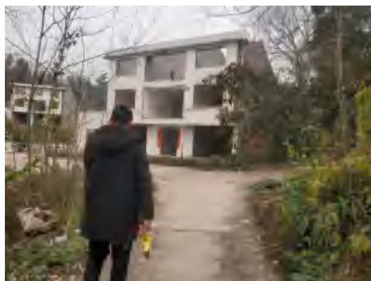
地块内东侧残留房屋
