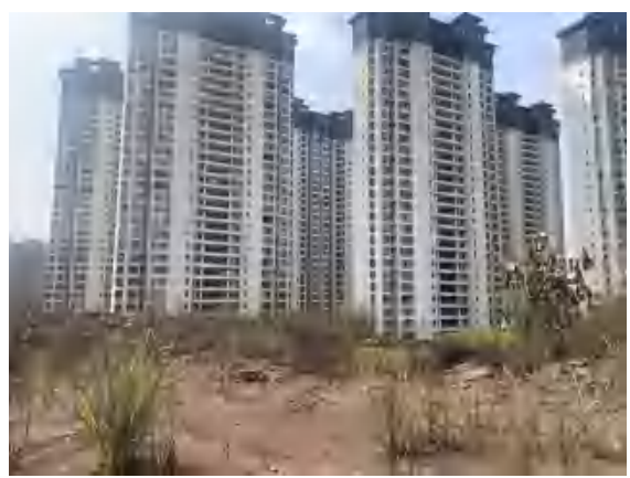
南侧外环境（置信丽府，拍摄方向：西南）
