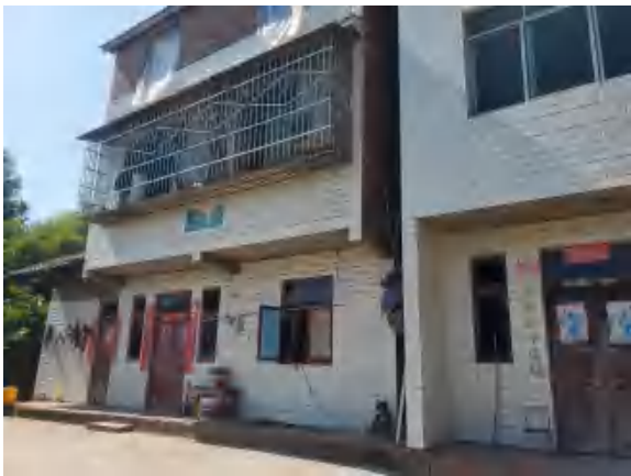
地块内南侧房屋
