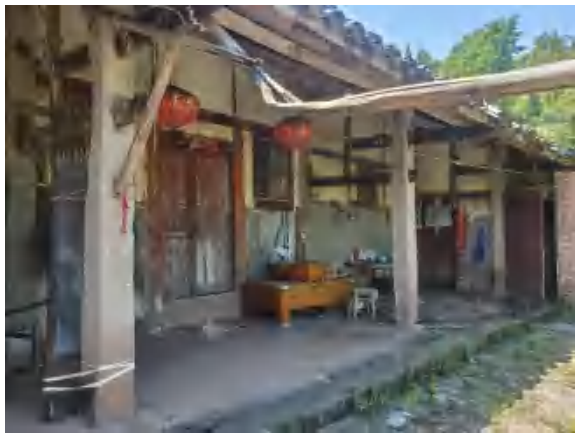
地块内西北侧房屋（已废弃）
