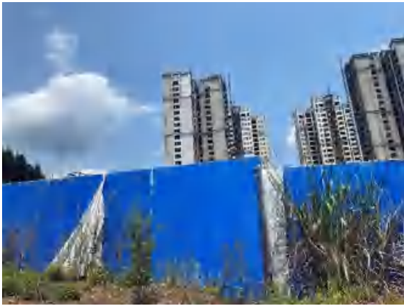
西北侧外环境（在建的锦玺公馆小区，照片编号#1，拍摄方向：西北）
