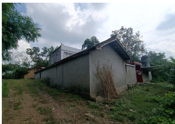
地块内南侧民房
