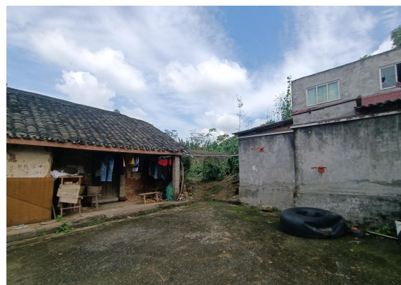
地块内南侧民房
