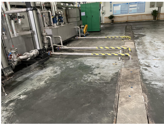
机加/装配车间内废水排放沟渠
