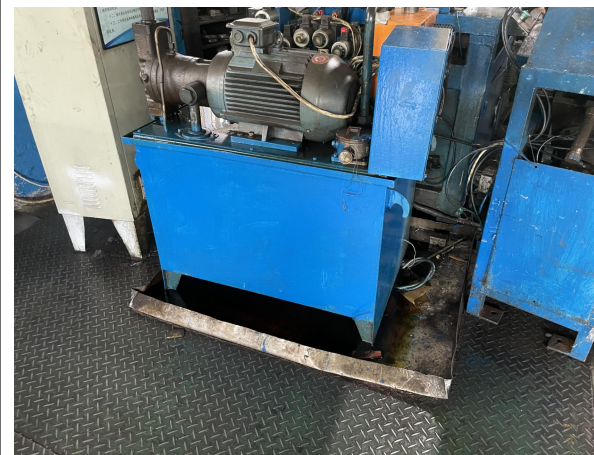
壳体车间内生产设备（设备设有托盘）
