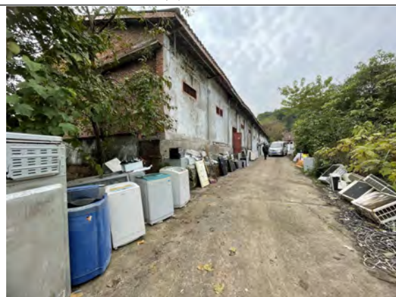
地块内企业中部水泥道路（照片编号 6#，拍摄方向：西南）
