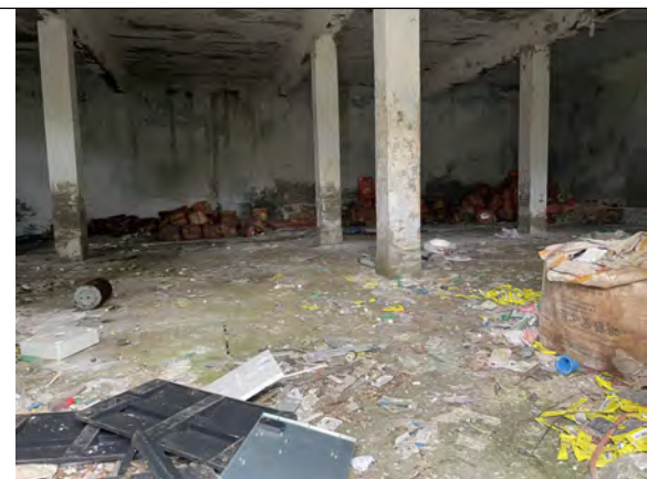
地块内 1 号构筑物内部（照片编号 7#，拍摄方向：东南）
