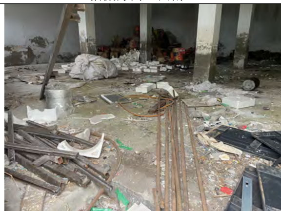
地块内 1 号构筑物内部（照片编号 8#，拍摄方向：西南）
