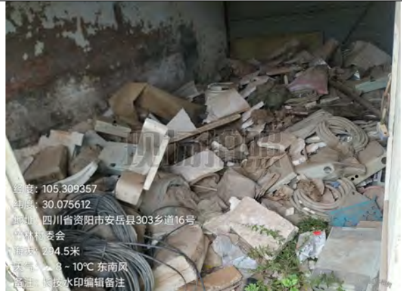
地块内 4 号构筑物内部（照片编号 4#，拍摄方向：北）
