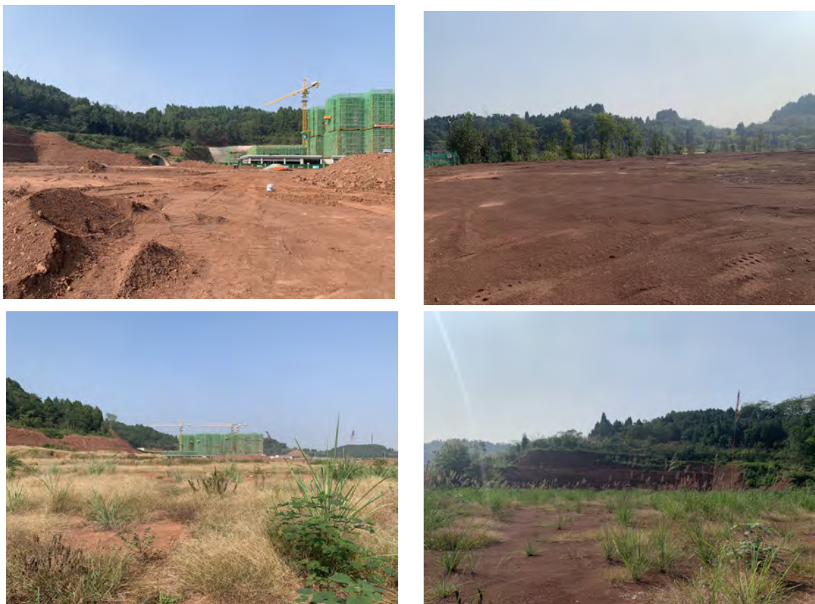
图 3.5-2 地块内现状照片
