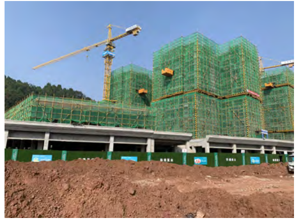
西北侧外环境（在建工地）
