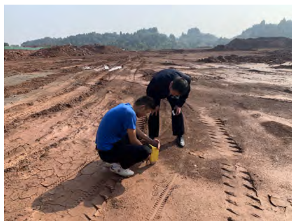
现场踏勘照片（吴文著，资阳市自然资源和规划局临空经济区分局，土地使用者）
