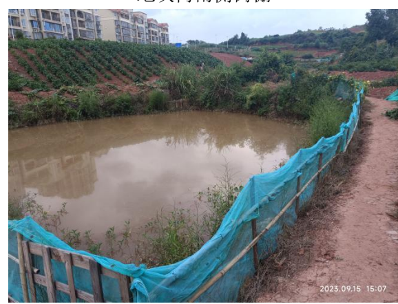
地块内西南侧雨水池
