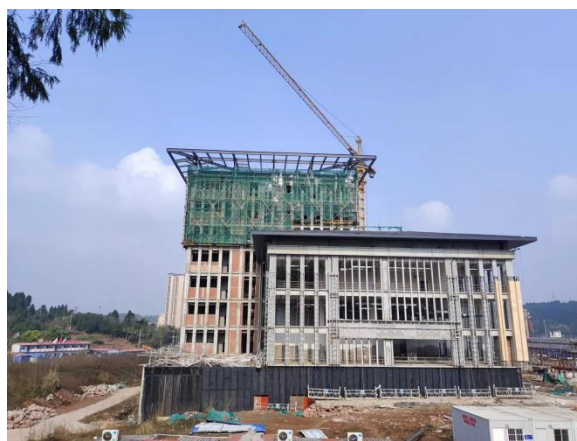
北侧外环境 （安岳县公安局业务技术用房在建项目）
