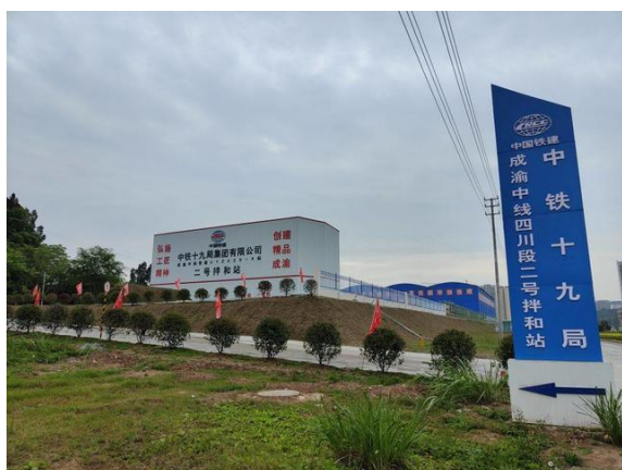
南侧外环境 （中铁十九局成渝中线四川段二号拌和站）
