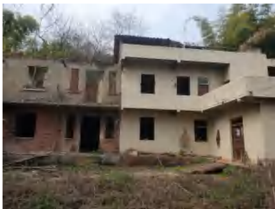
地块内残余房屋
