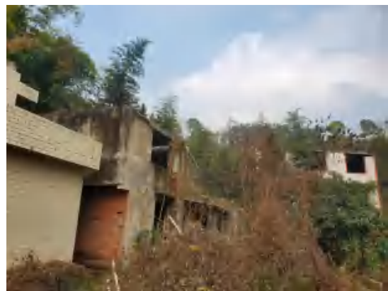
地块内残余房屋
