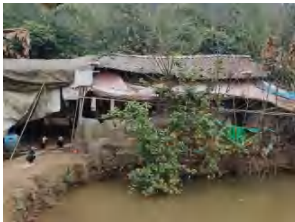
地块内中部残留房屋
