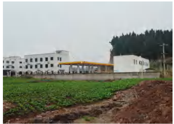
东南侧外环境（安岳县残疾人托养中心和壳牌加油站）
