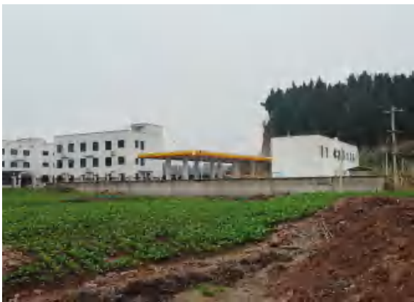
东南侧外环境 （安岳县残疾人托养中心和壳牌加油站）
