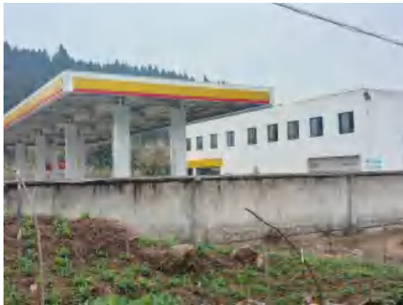
地块内西南侧堆土
