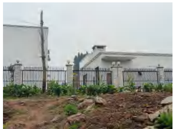
地块内西南侧堆土
