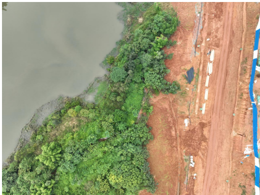
地块内西侧（荒地、林地）
