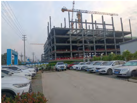
南侧外环境（在建工地）
