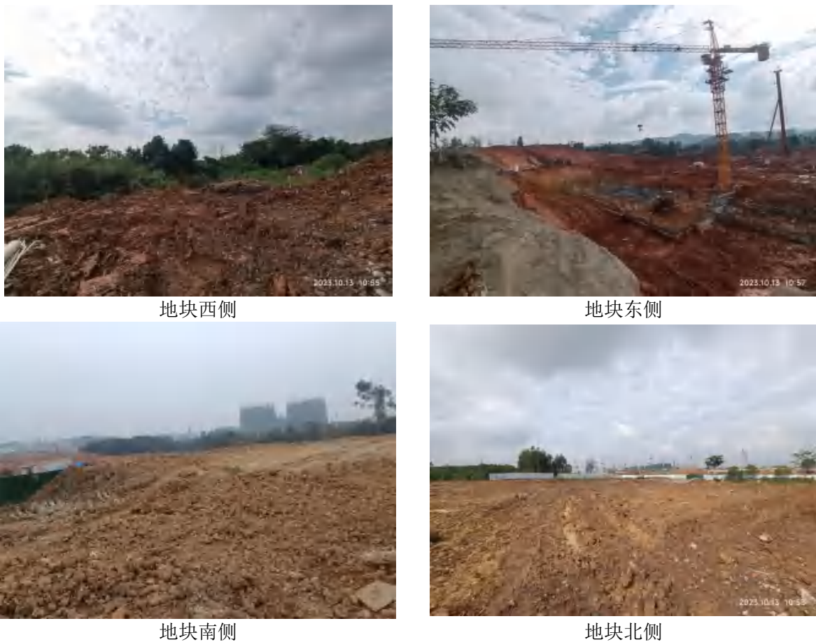
图 3.5-1 地块内现状照片
