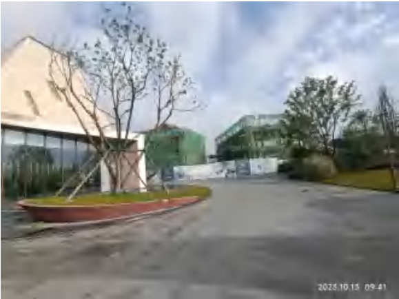
西侧外环境（在建工程）
