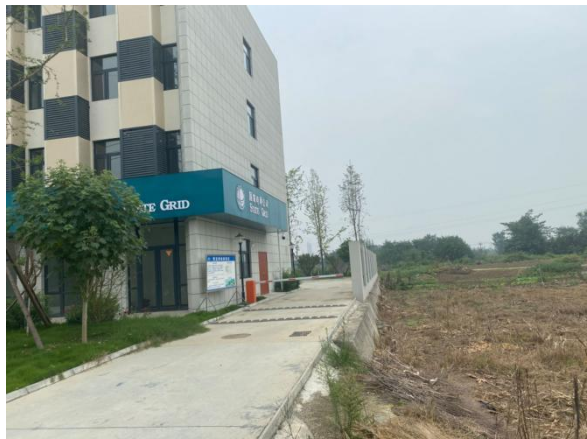
东南侧外环境（国家电网公司（未使用的建筑物），照片编号#4，拍摄方向：北）
