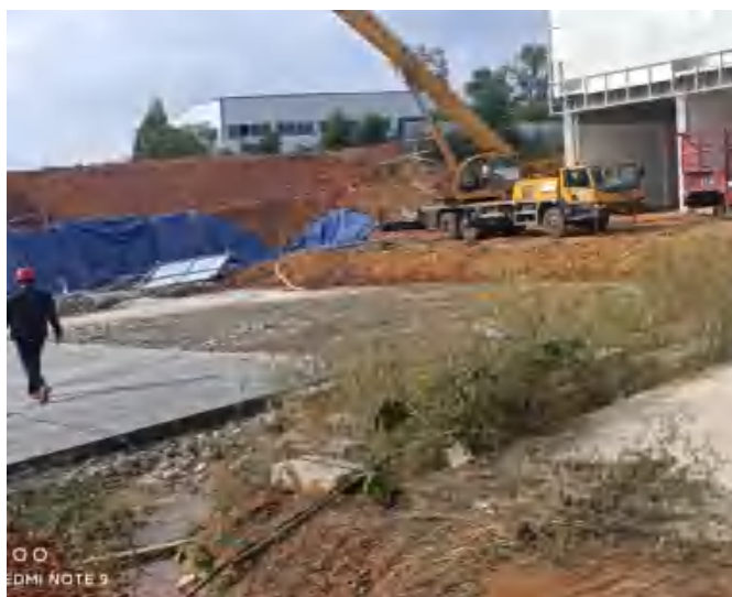
东侧外环境（在建消防站）
