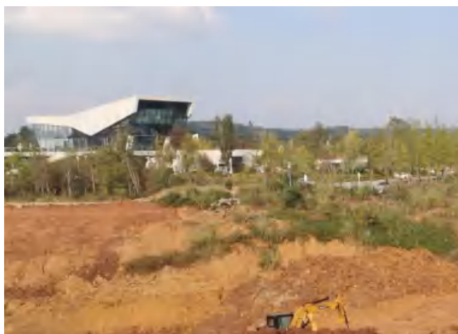
西侧、南侧外环境（绿化，整治中）
