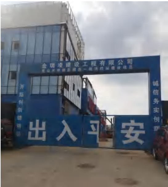
地块内东侧（在建消防站）
