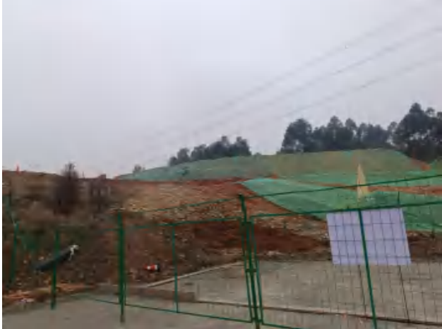
南侧外环境（林地、在建工程）
