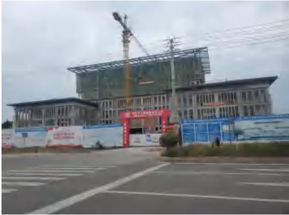
东侧外环境 (安岳县公安局业务技术用房在建项目)
