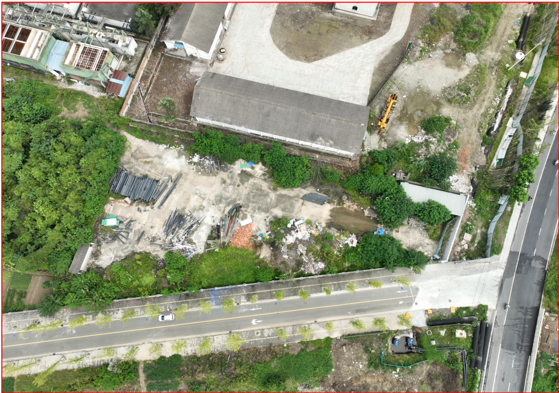
地块内硬化地面
