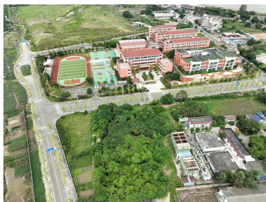
北侧四川水亿青龙自来水厂未建设区域
