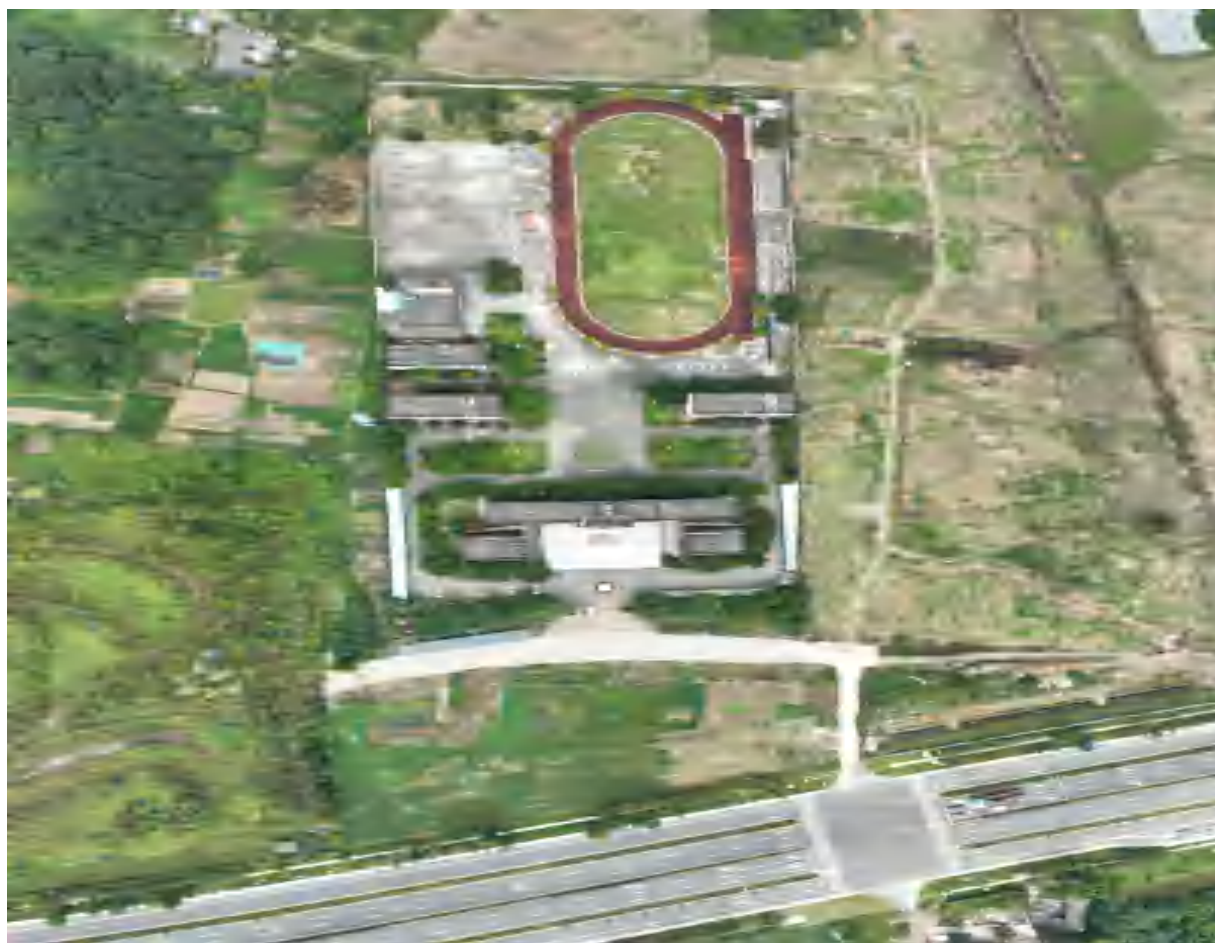
地块内现状航拍图
