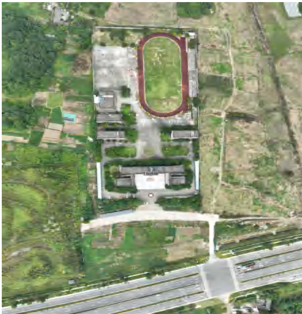
图 3.5-2 地块内现状航拍图
