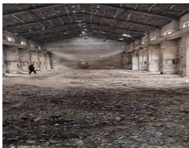
精加工车间（切割、焊接、刷漆工序均在此车间进行，不同工序间的边界已拆除）
