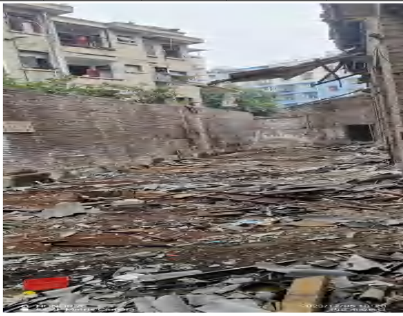
厂房拆除后产生建渣
