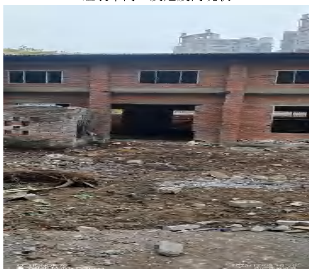
库房外现状（部分拆除）
