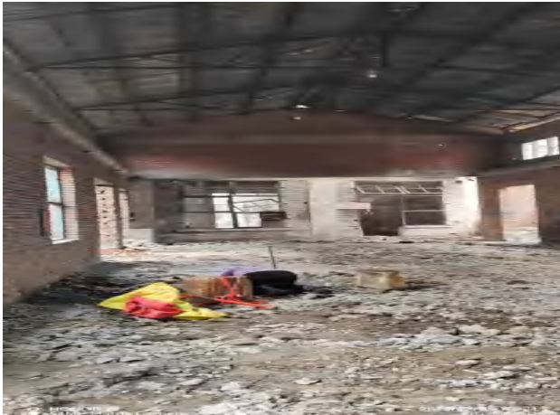
组装车间 1 及危废暂存间（厂房内部设备已拆除， 无危废堆放，仅有建渣）
