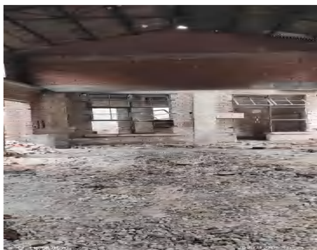
组装车间 1 及危废间现状
