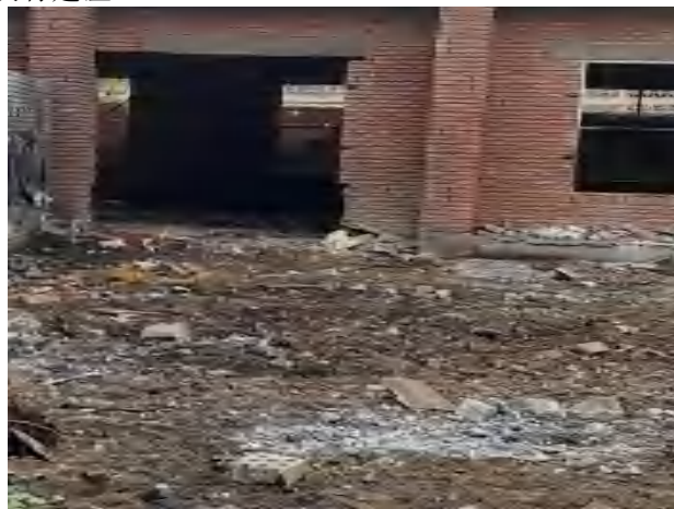
库房（部分拆除）
